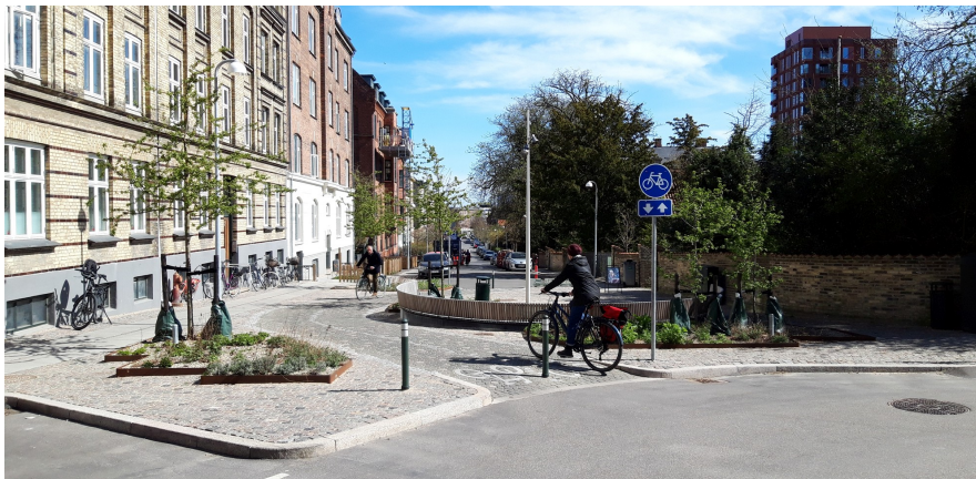
Abb. 2.: Diese Einmündung in Kopenhagen wurde baulich so umgestaltet, dass Fuß- und Radverkehr weiter passieren kann und Kfz-Verkehr rechts abbiegt. Die gewonnenen Flächen dienen der Naherholung. (Foto: H. Hagedorn)
