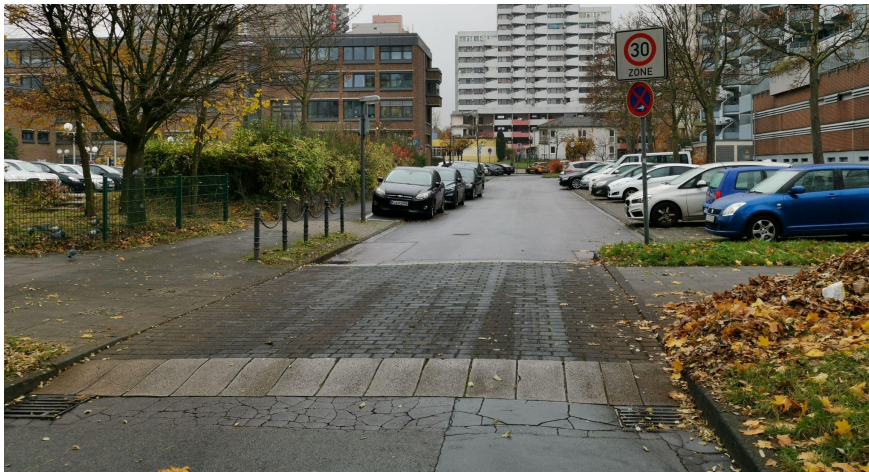
Abb 6: Aufpflasterung in Köln für den querenden Fußverkehr (Foto: QIMBY)
